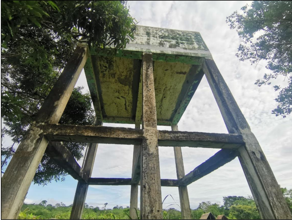
Imagen # 5 – Vista de tanque de agua del Puesto de Salud de Púcuru, actualmente en desuso.
