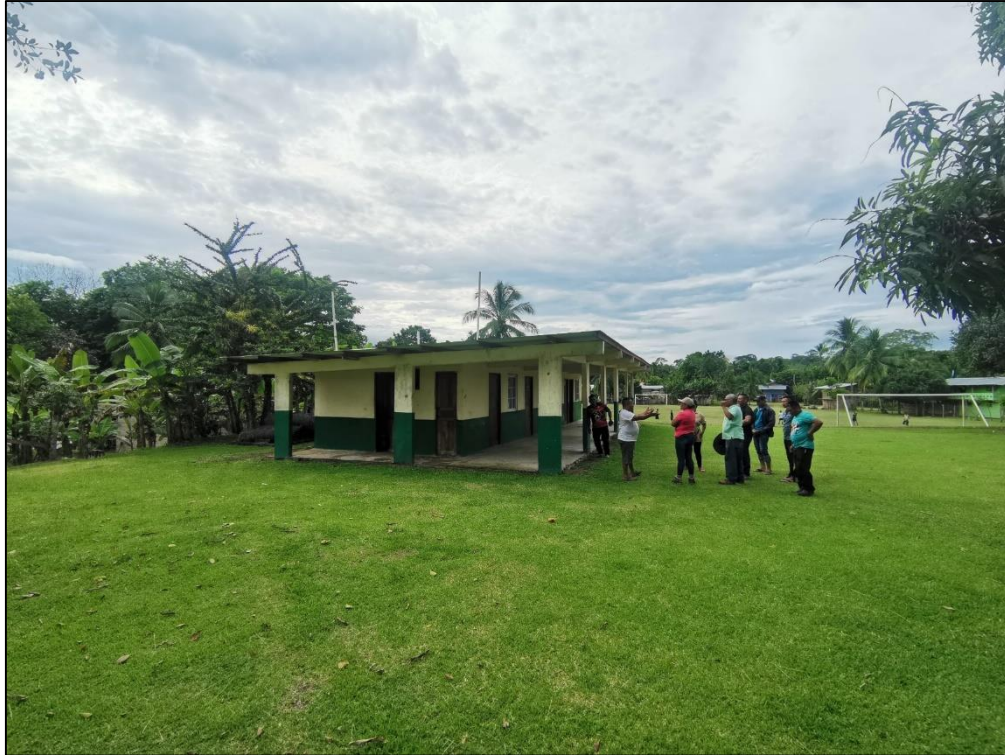
Imagen #9 – Puesto de salud actual con cancha de fútbol en parte posterior.
