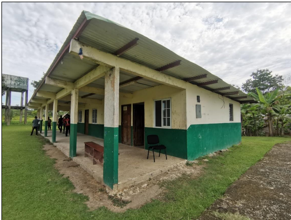
Imagen #8 – Puesto de Salud existente a ser rehabilitado para residencia de funcionarios.
