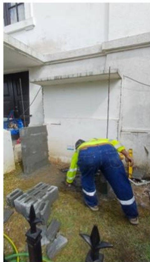
"EJECUCIÓN DE LA INSTALACIÓN DE NICHOS PARA TANQUE DE GAS, CONFORME A REQUERIMIENTO DEL BCBP"
