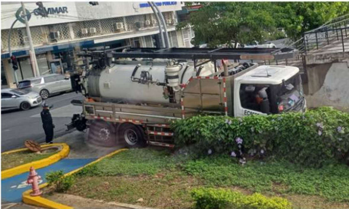
"MANTENIMIENTO Y LIMPIEZA DEL SISTEMA DE DRENAJE PLUVIAL EN EL ÁREA DE LA GOBERNACIÓN"
