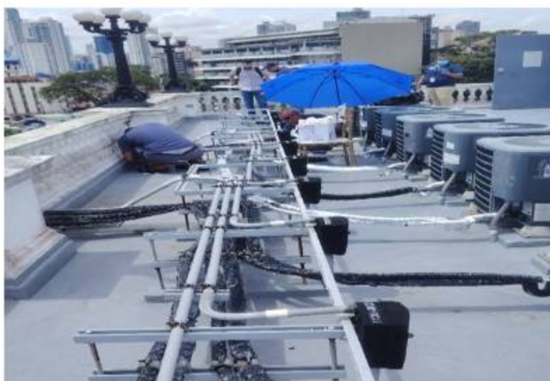
"SUSTITUCIÓN GENERAL DE AISLAMIENTO TÉRMICO TIPO ARMAFLEX Y REVESTIMIENTO DE TUBERÍAS PERTENECIENTES A LOS SISTEMAS DE AIRE ACONDICIONADO"
