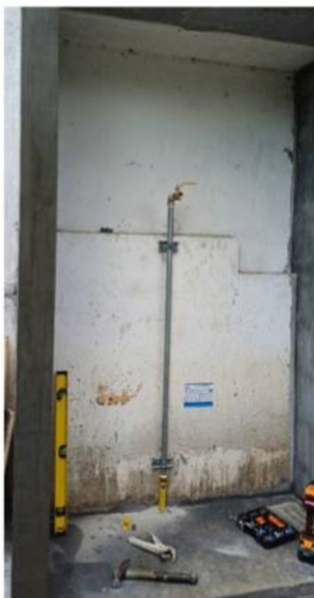
"EJECUCIÓN DE LA INSTALACIÓN DE NICHOS PARA TANQUE DE GAS, CONFORME A REQUERIMIENTO DEL BCBP"
