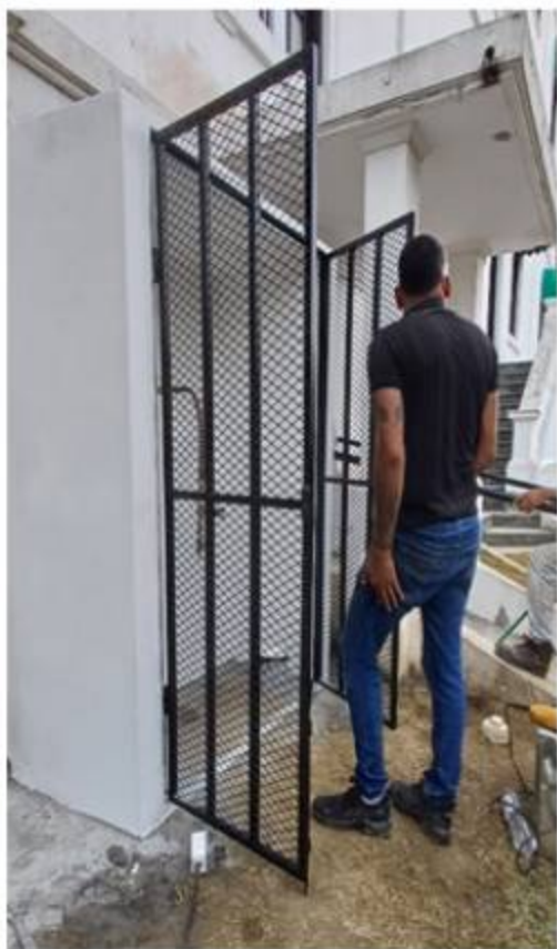
"EJECUCIÓN DE LA INSTALACIÓN DE NICHOS PARA TANQUE DE GAS, CONFORME A REQUERIMIENTO DEL BCBP"
