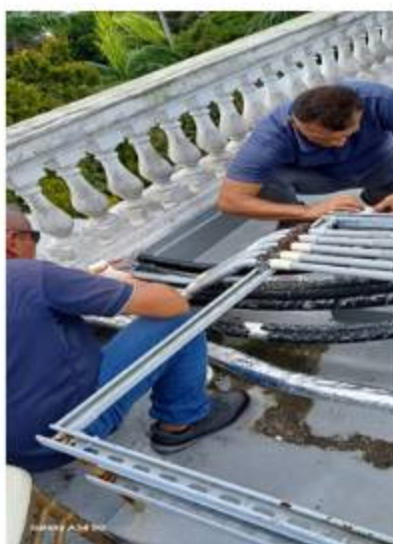
"SUSTITUCIÓN GENERAL DE AISLAMIENTO TÉRMICO TIPO ARMAFLEX Y REVESTIMIENTO DE TUBERÍAS PERTENECIENTES A LOS SISTEMAS DE AIRE ACONDICIONADO"
