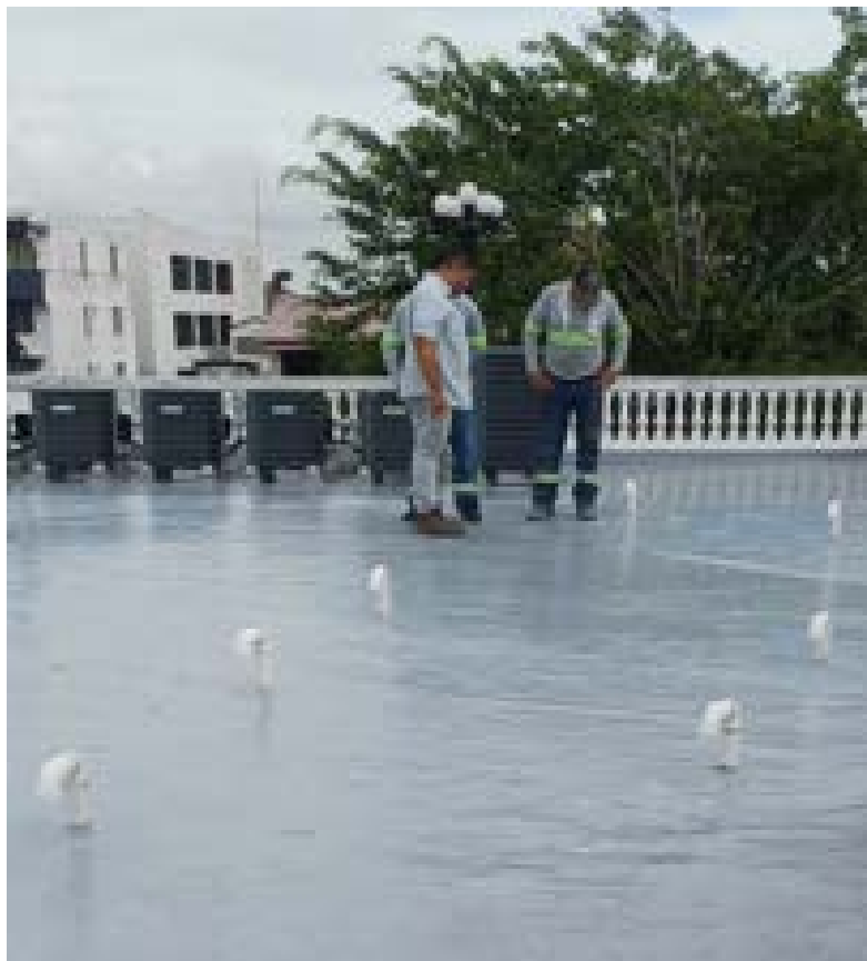
INSPECCIÓN DE RESPIRADEROS DE LA LOSA DEL EDIFICIO
