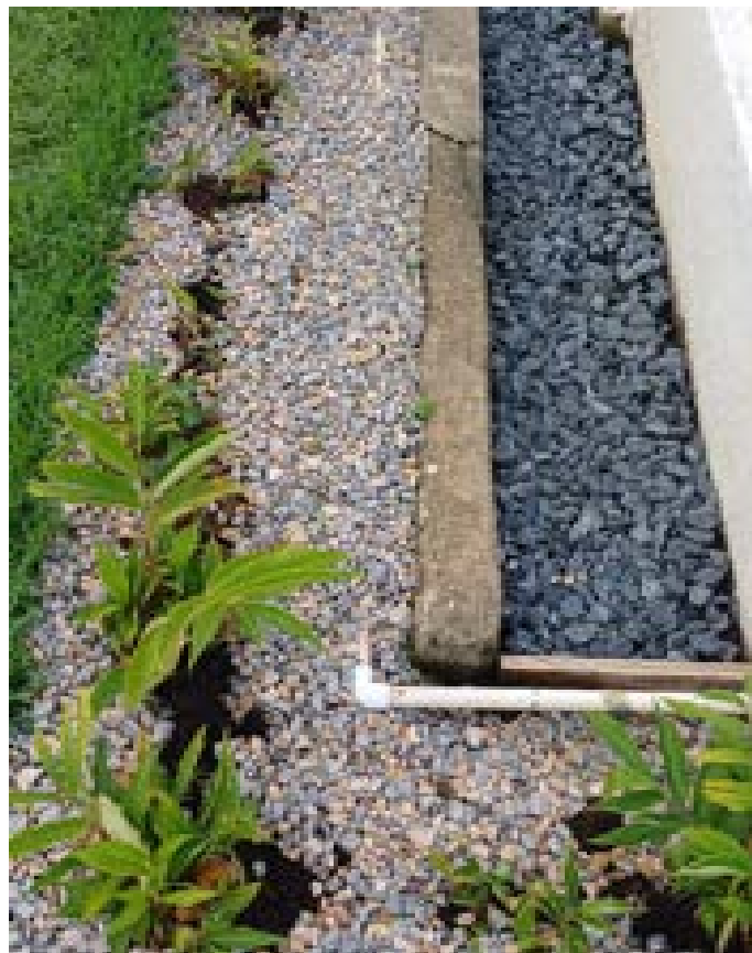
COLOCACIÓN DE PIEDRAS AL JARDÍN PARA EVITAR EROSIÓN
