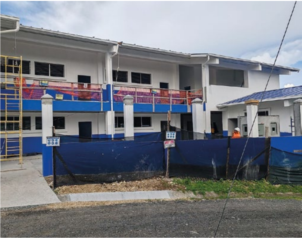
Obras en ejecución que benefician a 12,836 persona, por un monto estimado de B/. 26,379,065.43
